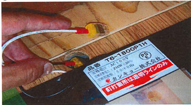
③溝加工と床下配線用の穴φ30加工(100V仕様)
