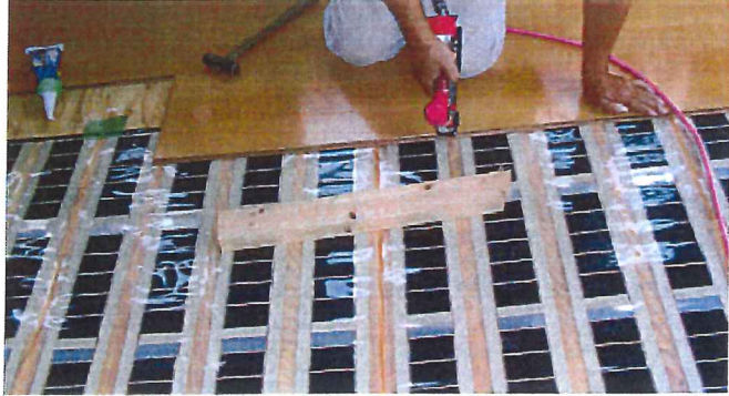
⑥フローリングへの釘固定
