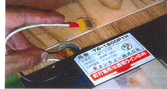
③溝加工と床下配線用の穴φ30加工(100V仕様)
