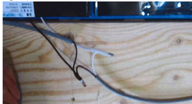
④圧着スリーブによる結線(200V仕様)
